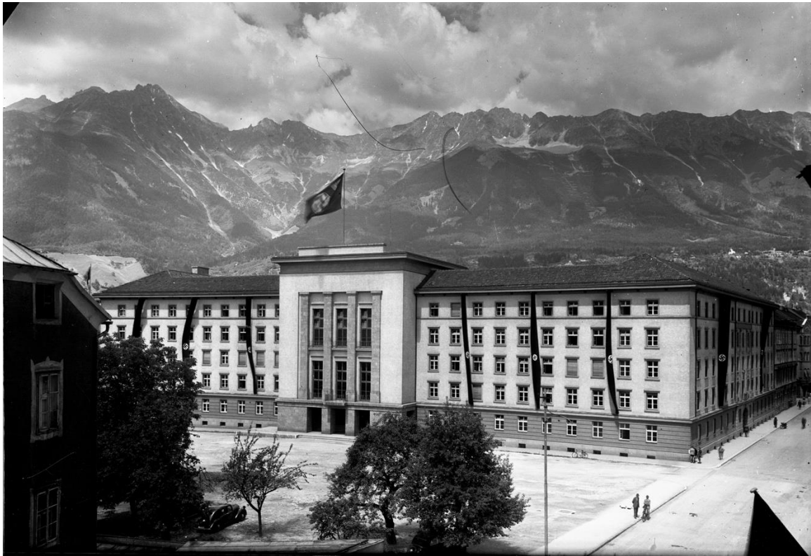
Abb. 21, Erweiterungsbau, nach 1939, Foto: Richard Müller (StAI, NL Richard Müller).
