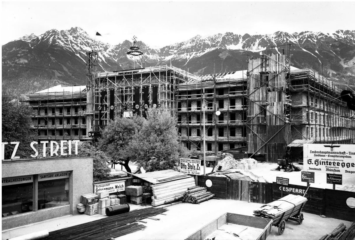
Abb. 32, Baustelle Erweiterungsbau mit Holzgerüsten, Materialaufzug und Fahnenmuck für die Firstfeier, Mai 1939, Foto: Richard Müller (StAl, NL Richard Müller).
