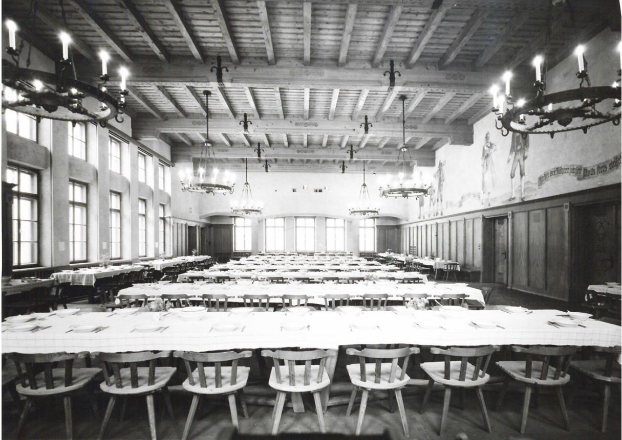
Abb. 40, Gemeinschaftssaal im Wirtschaftstrakt mit Holzvertäfelung, Türen mit Holzschnitzereien, schmiedeeisernen Radleuchten und Wandmalerei in Tiroler Art, Blick Richtung Osten, Foto: Reinhold Steiner (StAI, NL Reinhold Steiner).
