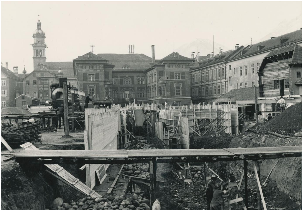
Abb. 31, Baustelle Erweiterungsbau, November 1938. Der Baubestand befand sich noch im Abbruch, zugleich erfolgte der Aushub für die Betonverschalung des Kellers. Links im Bild der „Kaisermischer“ zur Betonherstellung. Die Baustelle war in Bauabschnitten von Westen nach Osten organisiert. Foto: Fritz Popp (Tiroler Landesmuseen, Historische Sammlung).
