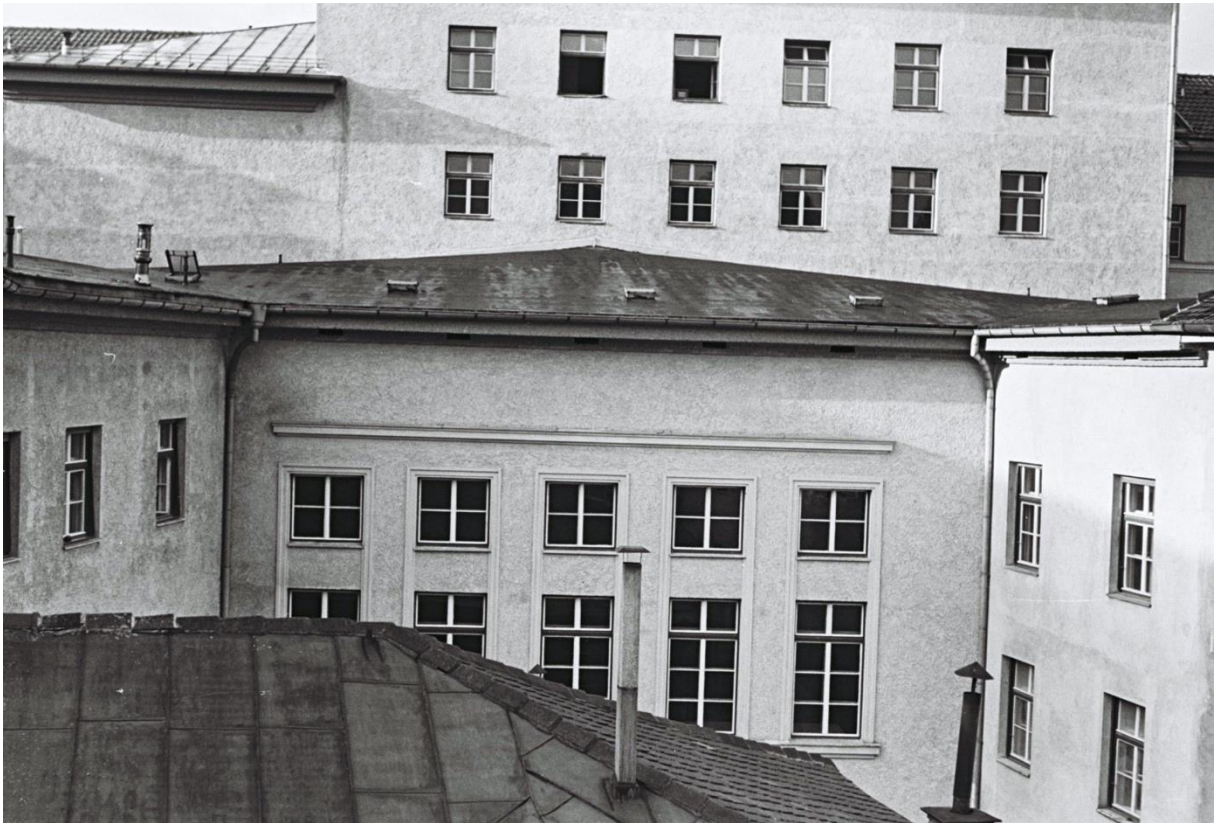
Abb. 41, Blick von Norden auf den Wirtschaftstrakt (StAI, Foto 4106_07).
